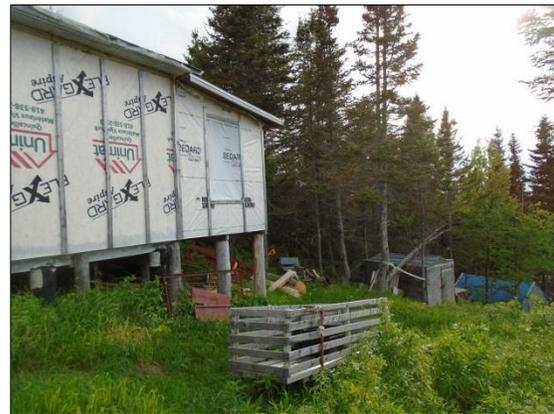
Photo 5 – Vide sous un bâtiment avec présence de combustibles
